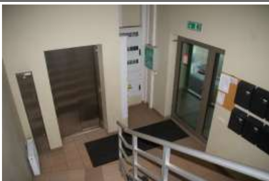
Būve ar kadastra apzīmējumu 1700032 0266 003, koplietošanas telpa
