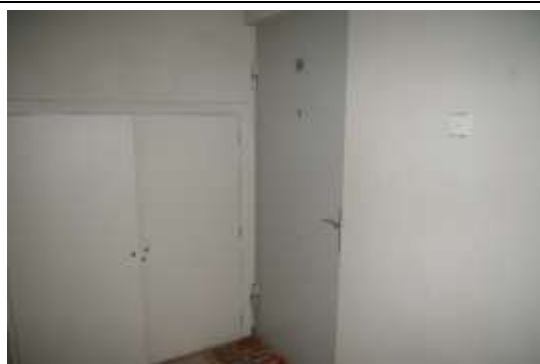
Būve ar kadastra apzīmējumu 1700032 0266 003, koplietošanas telpa
