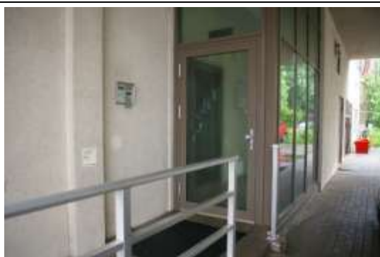
Būve ar kadastra apzīmējumu 1700032 0266 003, piekļuve pie vērtējamā Objektā
