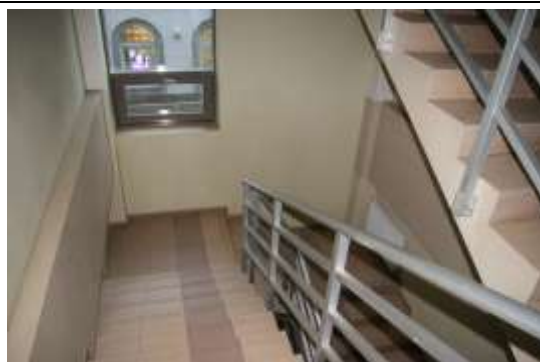
Būve ar kadastra apzīmējumu 1700032 0266 003, koplietošanas telpa
