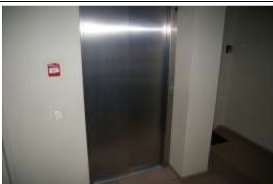
Būve ar kadastra apzīmējumu 1700032 0266 003, koplietošanas telpa, lifts
